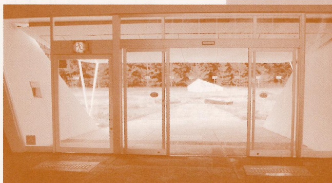
明るく改修された玄関ドア
